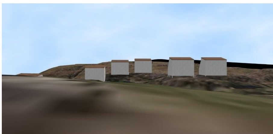
Figur 16 Oversikt over byggenes plassering i terrenget (sett fra nord til sør mot sjøen).
