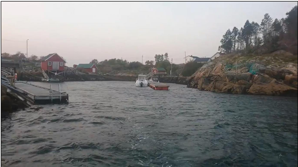
Bukta sett fra sør med sjøboden til venstre, flytebrygge langs moloen til venstre, berg til høyre og flytebryggeanlegg for småbåter innover i bukta mot land. Trær og busker sammen med lave bygningstak, lavspenmaster og berg, danner silhuetten. Foto: Henrik Berger
