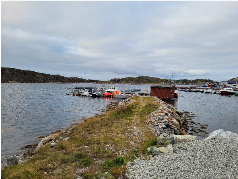
Figur 5: Foto av eksisterende molo og småbåthavn.
