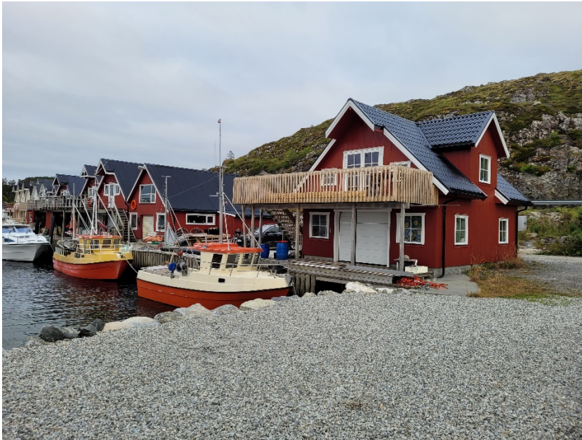
Figur 10: Foto av eksisterende bebyggelse i området.
