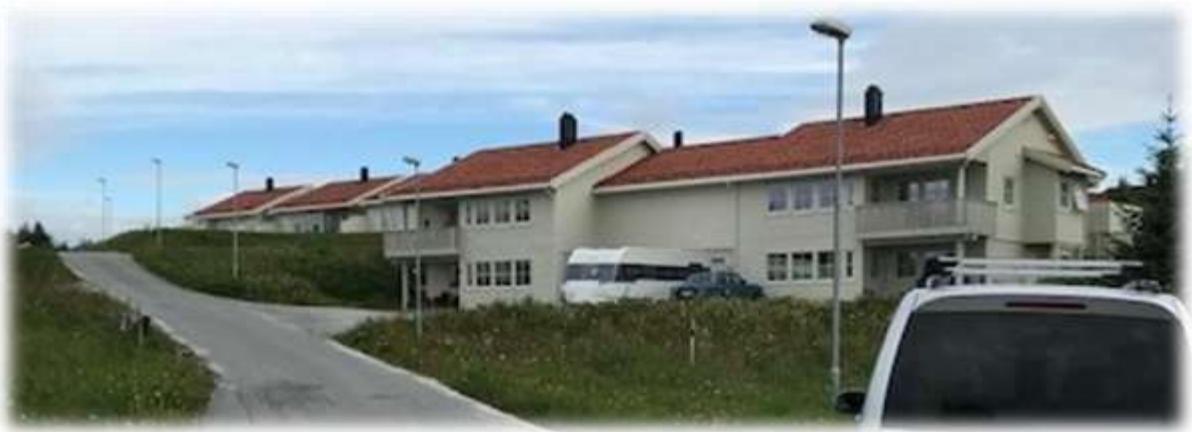
Figur 19 viser deler av eksisterende byggefelt Djupmyra.
