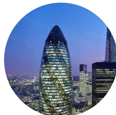
Figur 6.6 Avrundede hjørner på fasaden
