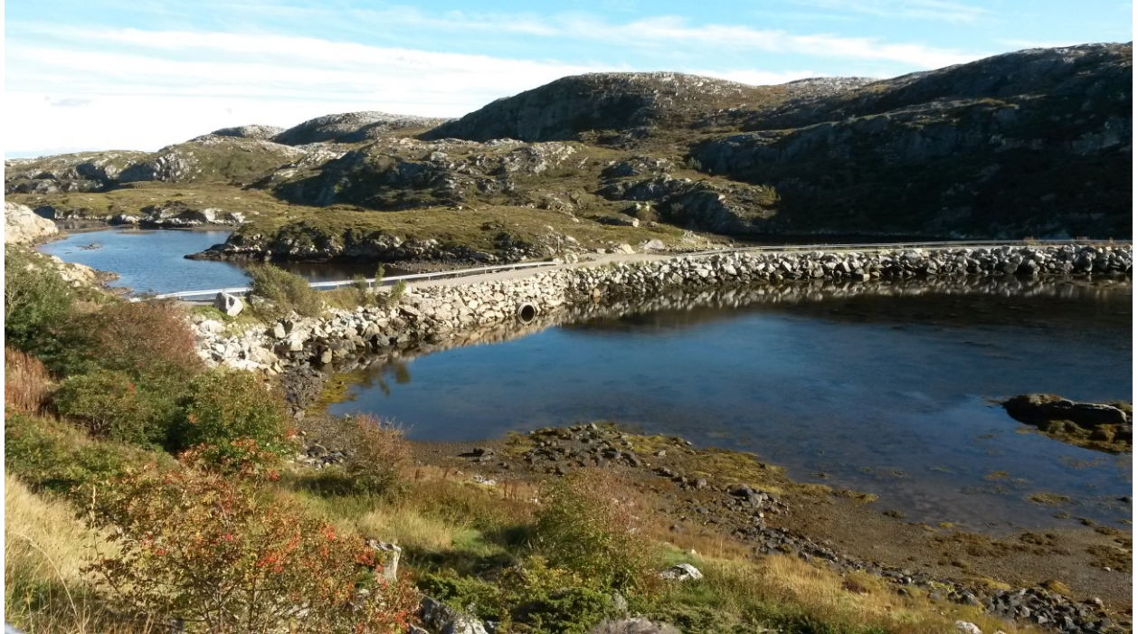
Oversiktsbildet over Buaveien som krysser Veisfjorden, med ny stikkrenne, rør med diameter 2m. Foto Øyvør Helstad
