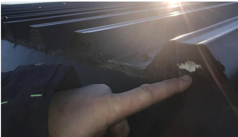
Bilde B 1 - Takplater langs raft på framsiden av HASA-bygget.
