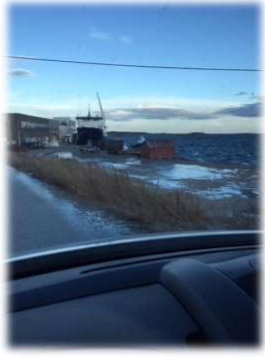
Figur 15 Bildet viser området småbåthavn land sett fra veien i sør mot nord
