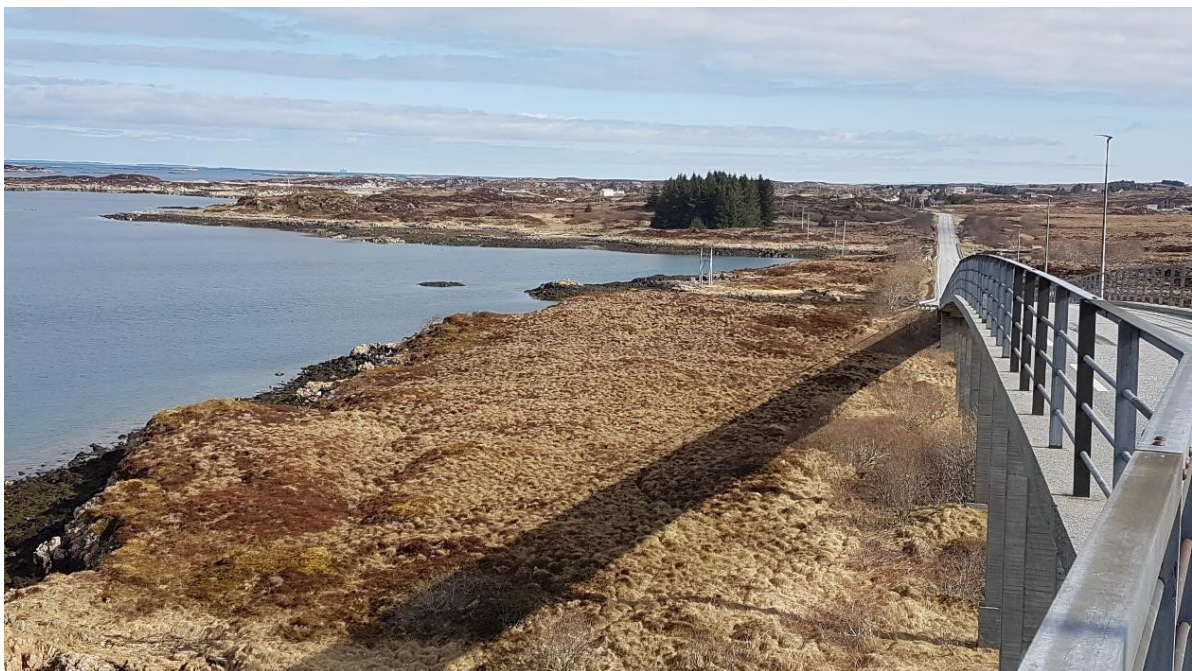
Figur 5. Planområdet sett mot vest fra brua over Eillingsundet
