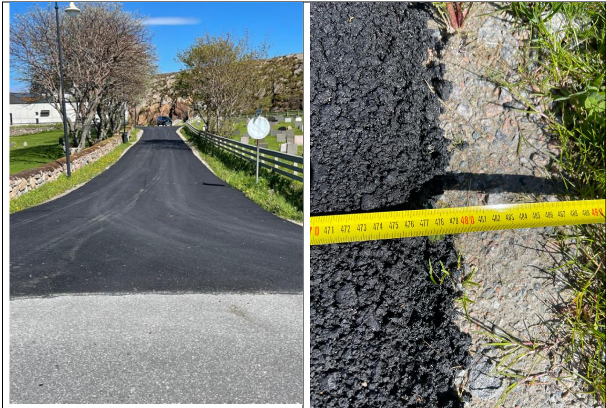
Bildet til venstre viser krysset fv 6472-Bergeveien. Bildet til høyre viser bredden på asfaltdekke på Bergeveien
