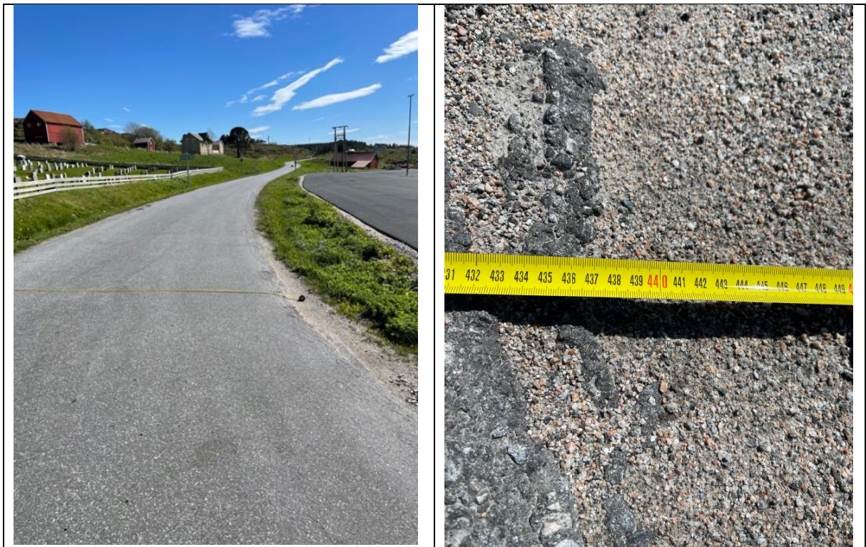
Bildet til venstre viser fv 6472 mot sør. Bildet til høyre viser bredden på asfaltdekket
