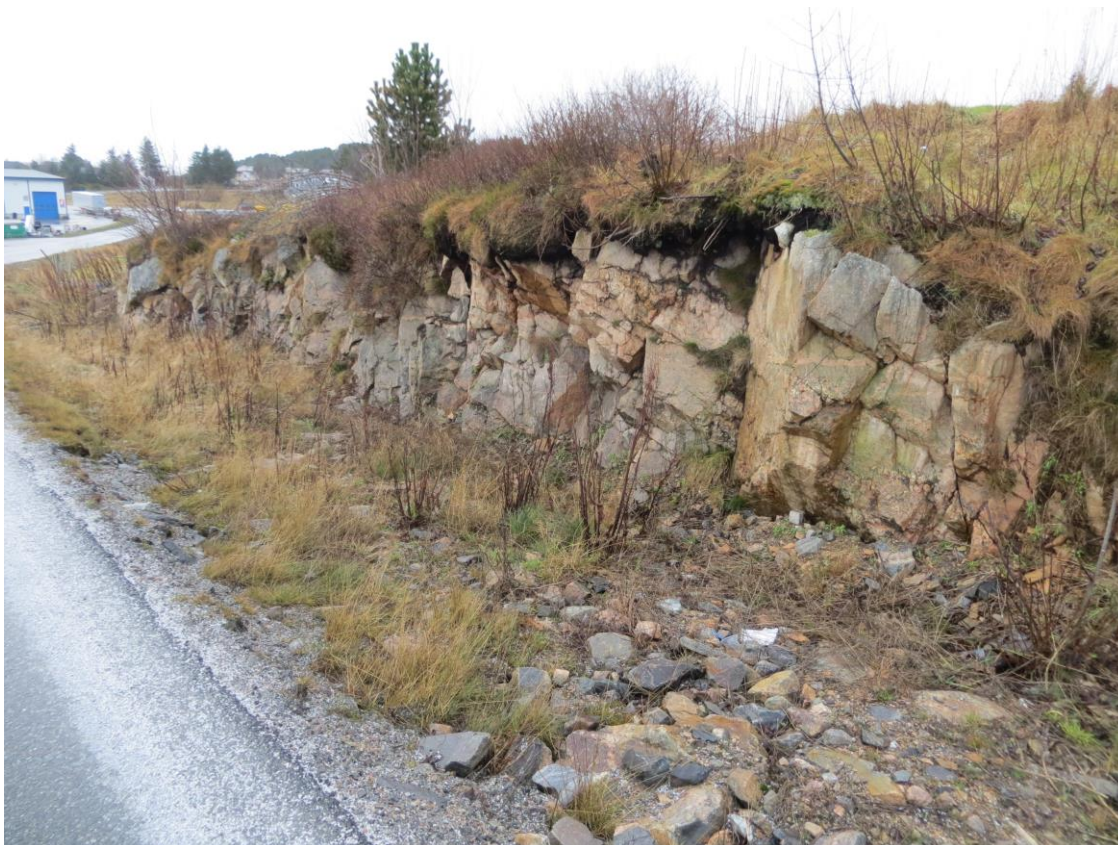
Figur16 Veiskjæring ved nordlige del av planarealet. Tynn humus på fjellet. Ingen tegn til leire - fast fjell ca. på kote 10.
