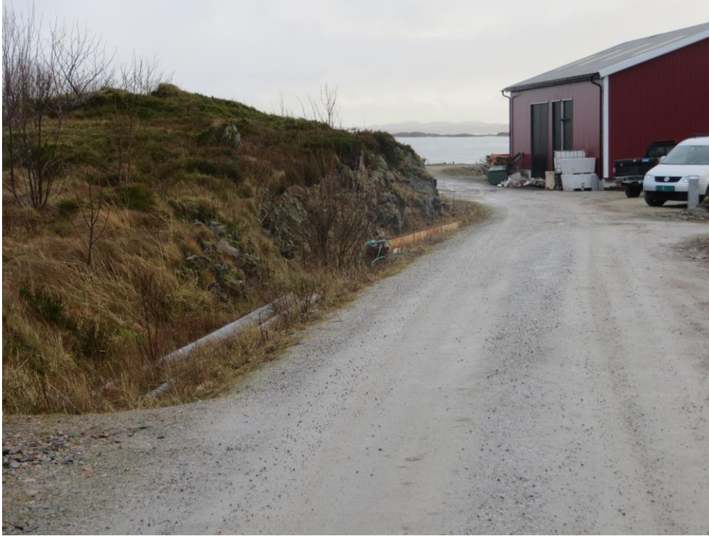
Figur 14 Veiskjæring lang vestlig margin av arealet. Fjell med tynn humus, ingen tegn til leire observert langs skjæringene i sør og mot nordvest.
