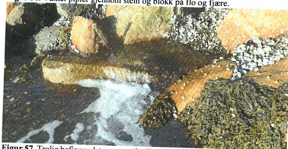
Figur 57. Trolig befinner det seg et underdimensjonert rør inne i forbygningen, men dette er da dekket av stein.
