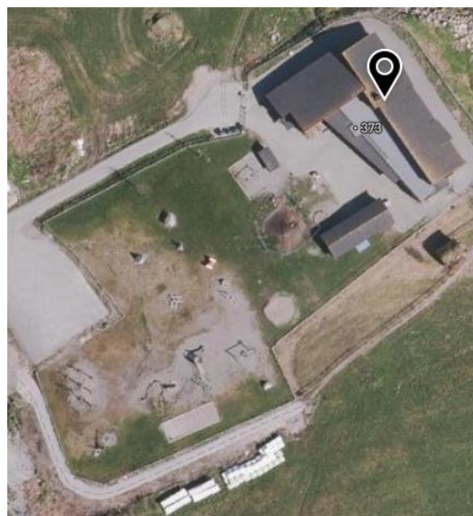
Oversiktsbilde av barnehagen, bygninger og uteområde
