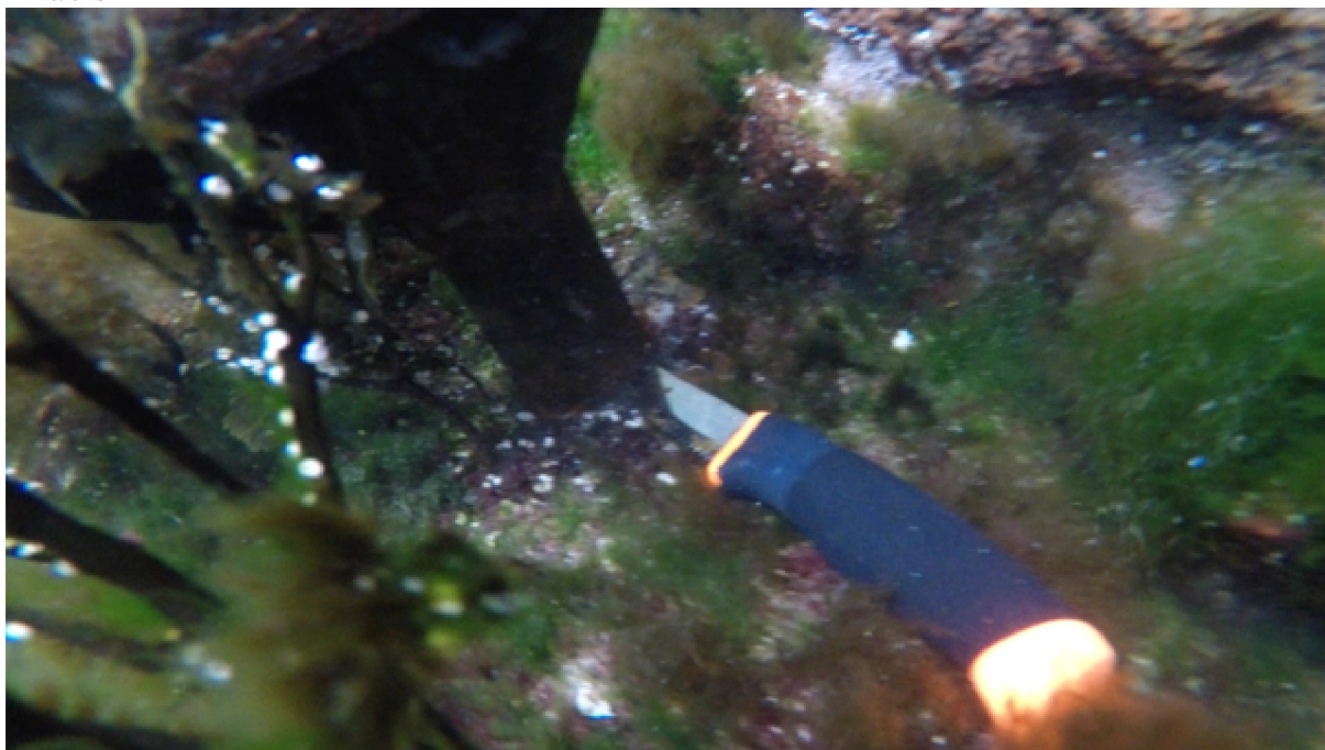
Bilde av søyle mot bunn, den er ikke festet i fjell og vi kan ta kniv under...
