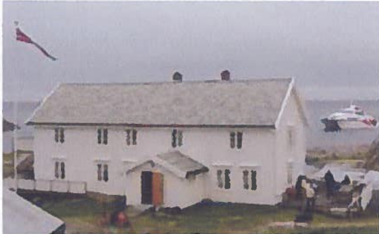
Oversiktsbilde av Skanklåna med plattformen i enden.
