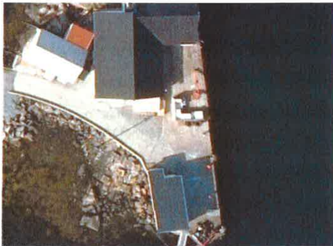
Kaianlegg på Sørurøy, halvdel av kai lengst nede på bildet benyttes som anløpskai.
