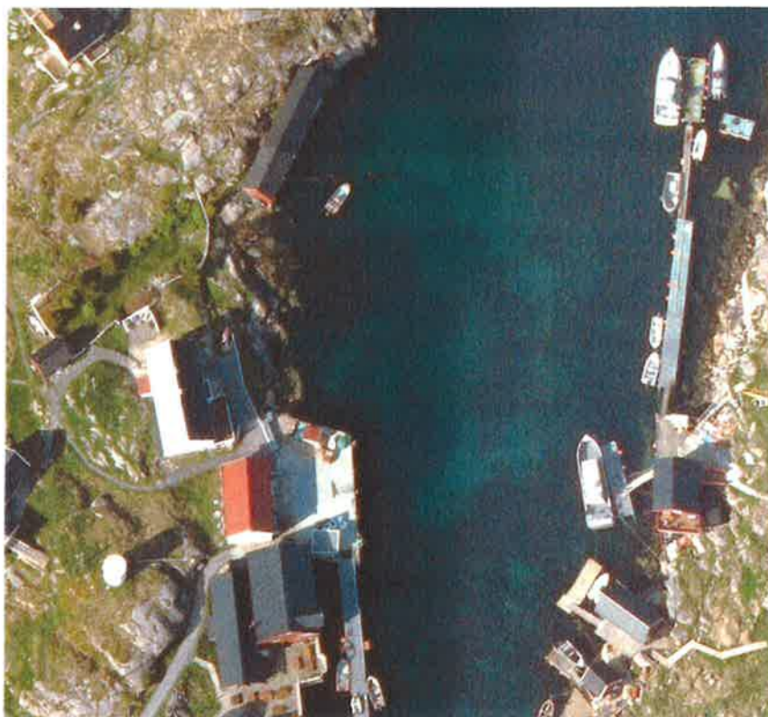
Kaianlegg på Bogøyvær.
