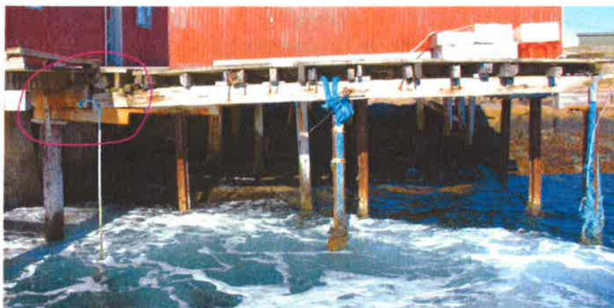
"Nabokai" mot øst. Bærebjelke i front hviler på "hovedkai".
