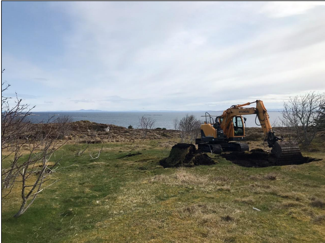
Figur 1: Adrian Vaagø fra KN Entreprenør AS bak spakene på sin 15t Hyundai gravemaskin. Tatt mot: Ø. Foto: Skule Spjelkavik/Trøndelag fylkeskommune.
