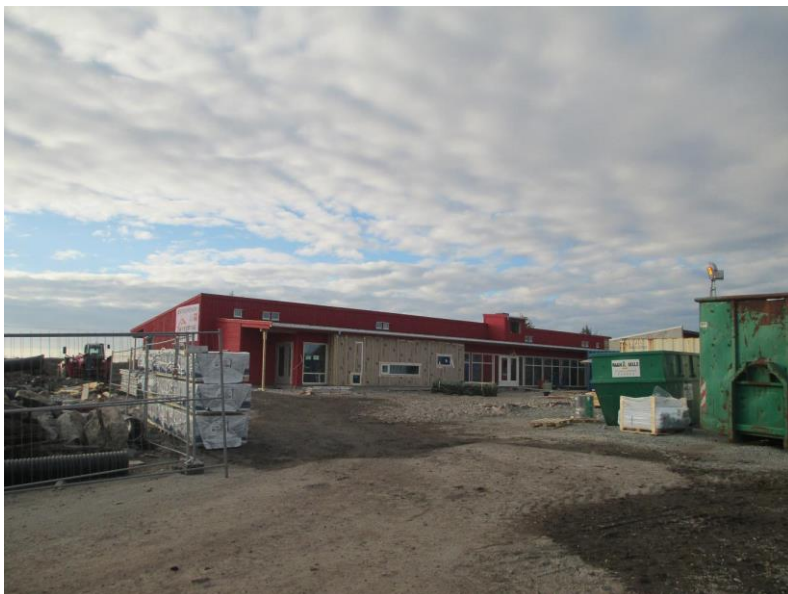
Ny barnehagen under bygging
