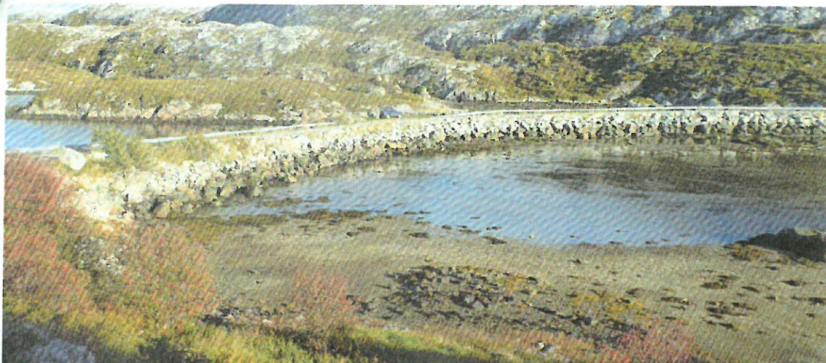
Figur 53. Veiforbygning og kommunal vei anlagt på tvers av indre Veisfjorden.
