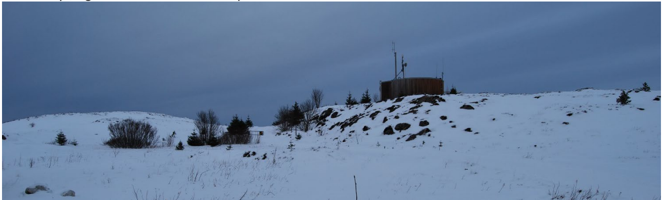
Figur 4. Dagens situasjon - Høydebassenget sett fra vest
