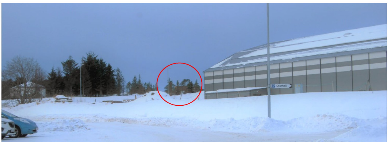
Figur 3. Dagens situasjon - Høydebasseng markert i rødt bak trær
