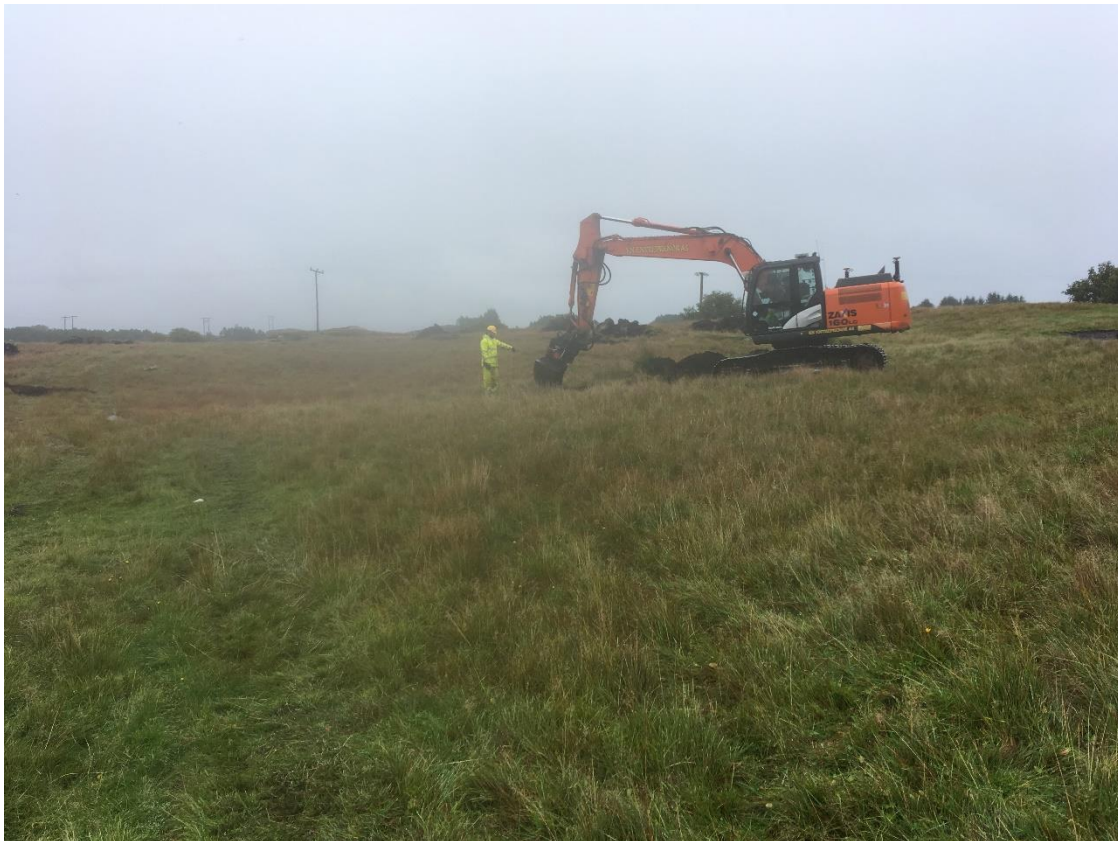
Figur 1 Våte forhold under graving, Coop Hamarvik. Foto: Synne Husby Rostad/Trøndelag fylkeskommune
