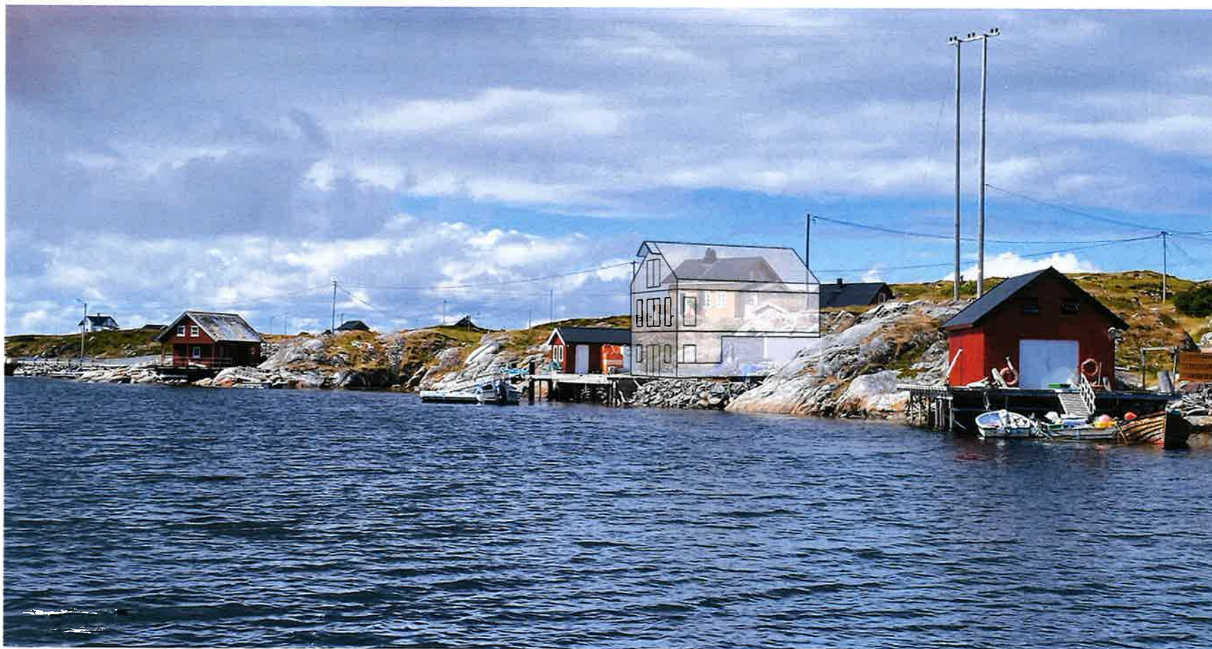
Tiltaket sett fra øst – transparent volum der pågående bygningsarbeider, bakenforliggende terreng samt fritidseiendom på Gnr 65/Bnr 305 fremgår
