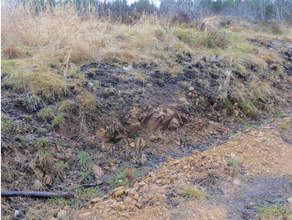
Figur 15 Skjæring langs østlige del av planarealet bekrefter tynn humus -/torvlag på fjellet
