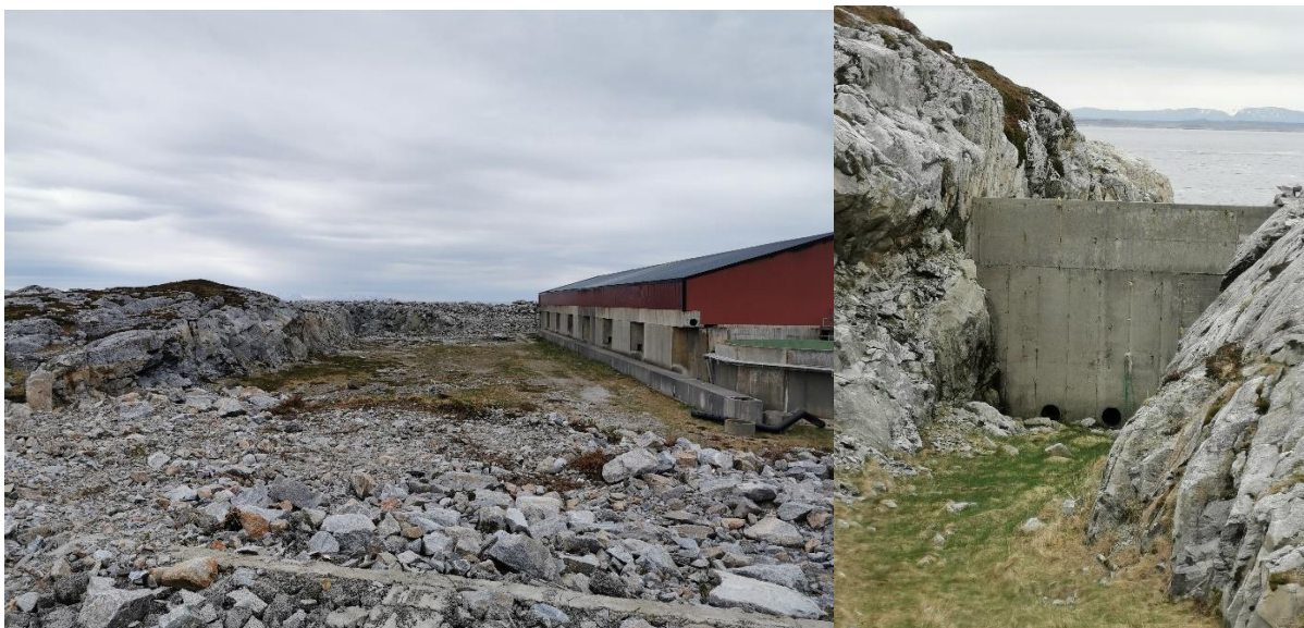
FIGUR 18 - JORD OG STEINVOLL RUNDT ANLEGG OG BETONGMUR MOT SJØ
