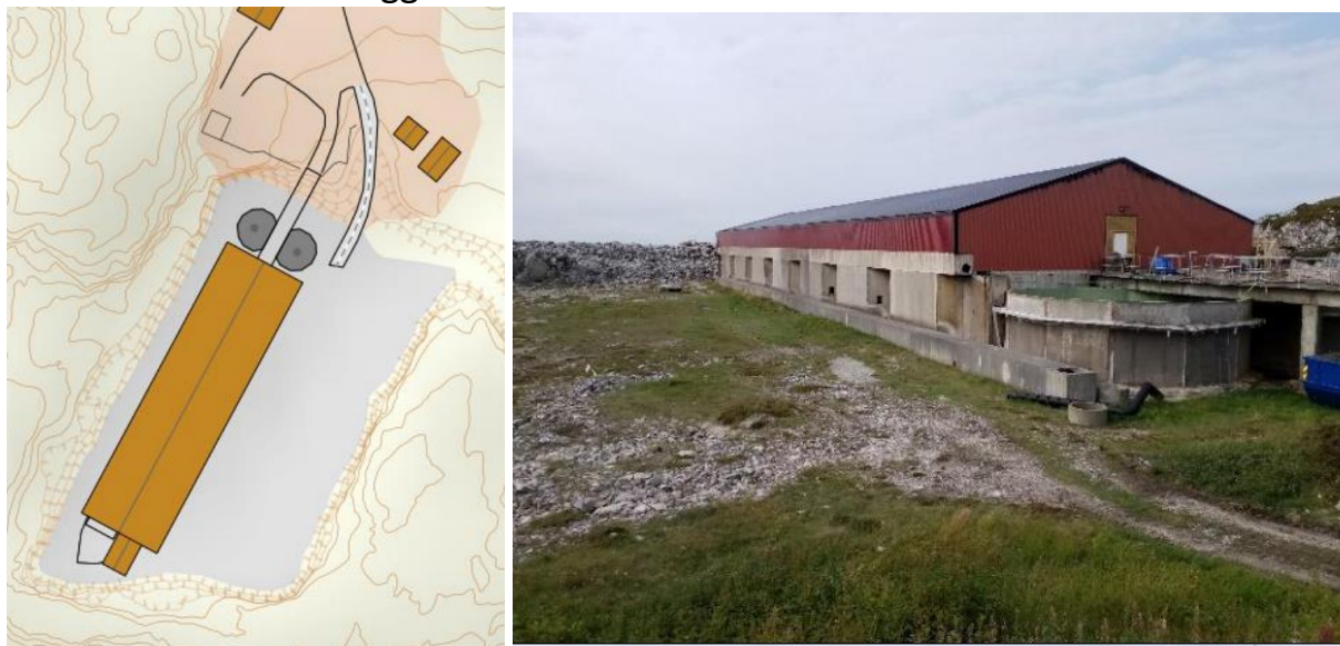
FIGUR 5 - OVERSIKT UTSPRENGT TOMT OG OMRÅDE FOR ETABLERING AV NYTT ANLEGG KILDE: RAMBØLL
