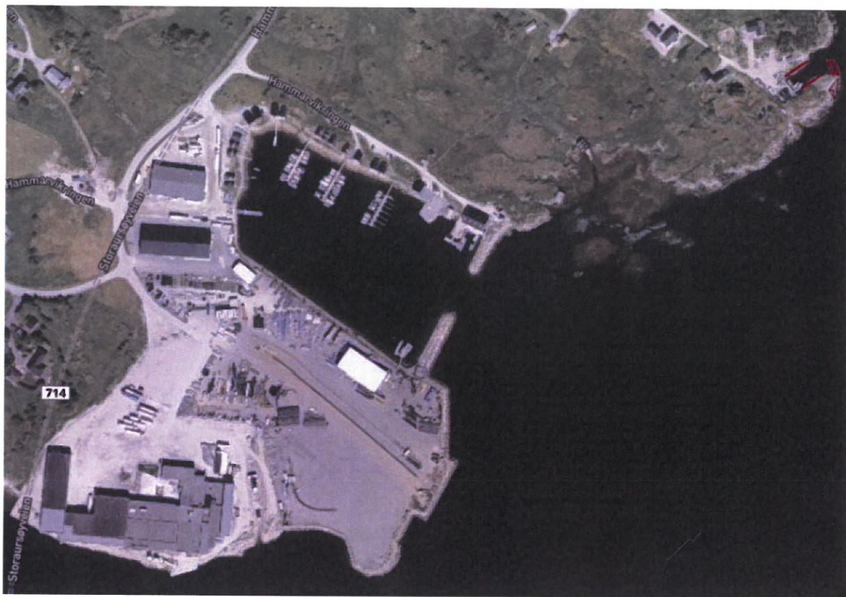
Flyfoto av Hammarvikbukta og Nordhammervikbukta: her vises havna på naboeiendommen og det omsøkte tiltaket inntegnet oppe i høyre hjørne.
