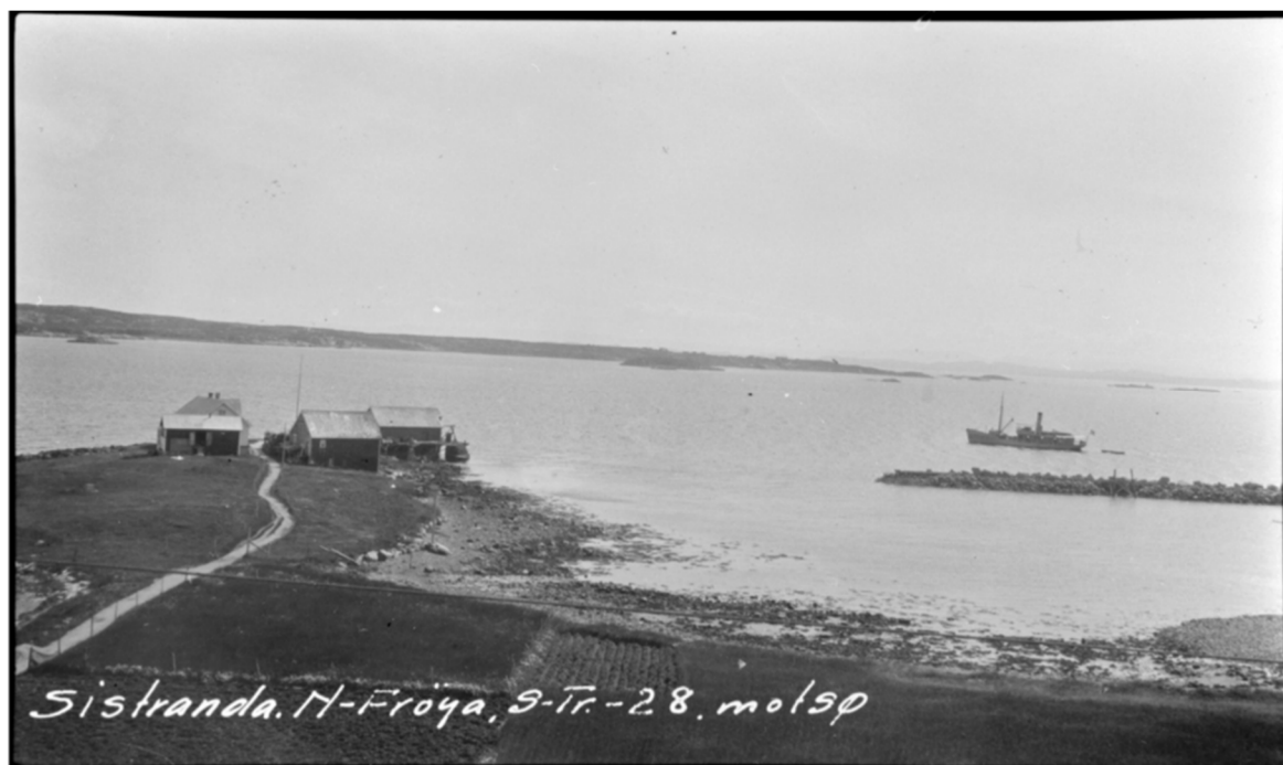
Figur 7 Siholmen sett fra vest i 1928. Molo sør for holmen er under bygging. Foto Statens Havnevesen
