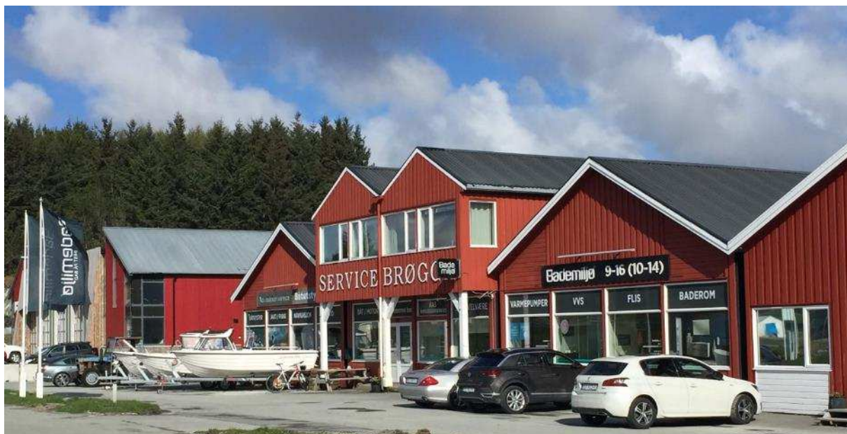
Figur 4 Servicebrygga med ulike næringsaktører og marina. Den nye brannstasjonen vises til venstre i bildet.
