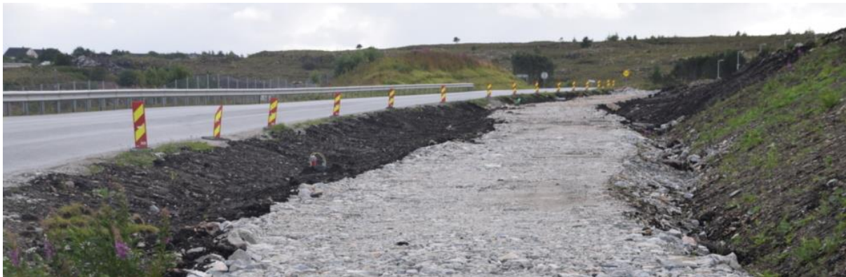
FIGUR 1: BYGGING AV GANG- OG SYKKELVEG HAMMARVIKA-SISTRANDA. FOTO: FROYA.NO
