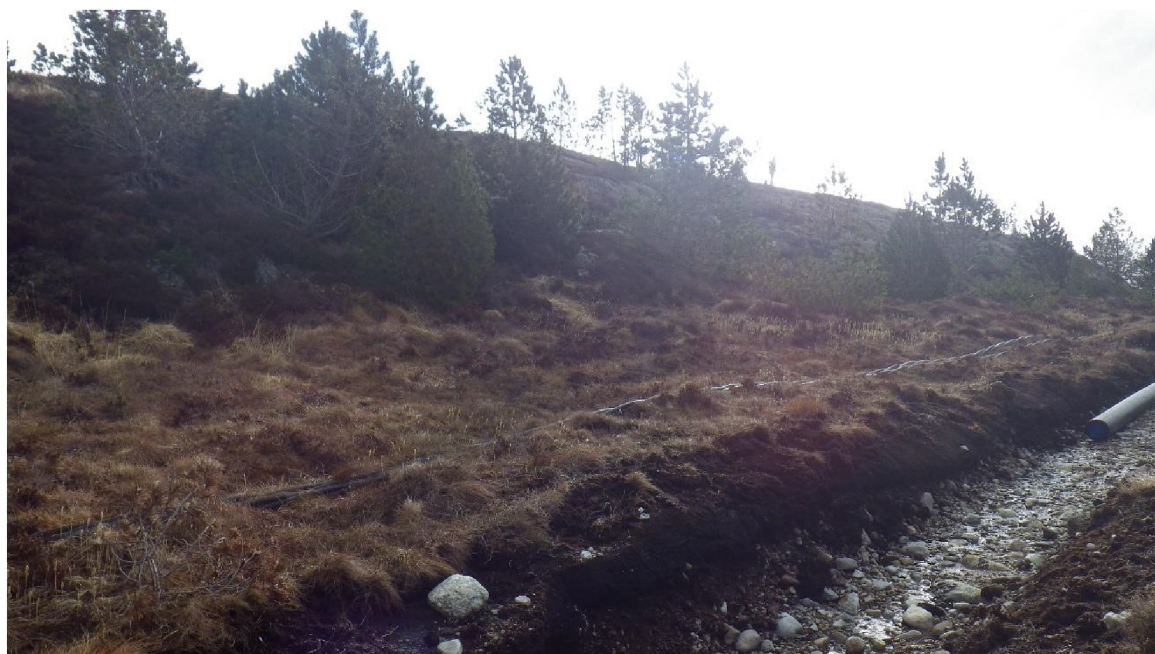
Figur 6: Ett av mange områder i traseen som var berørt av moderne inngrep. Dette lå helt i nord opp mot høyden det nye høydebassenget skulle legges. Foto: R. Øiangen
