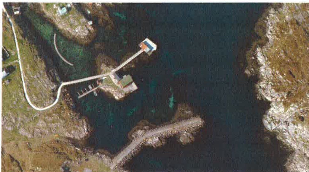
Kaianlegg på Sauøya.
