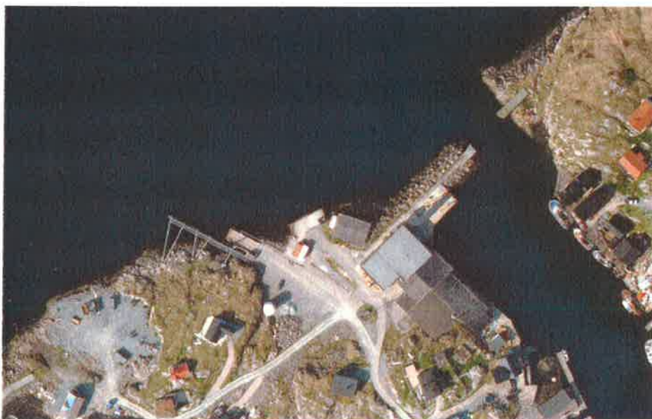
Kaianlegg på Mausund. Coop-kaia like til høyre for ferjekaia.
