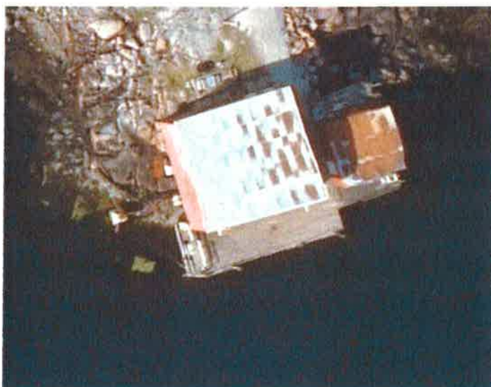
Kaianlegg på Gjæsingen. Nabokaia vises til høyre i bildet. Gamle konstruksjoner i sjøen vises like til venstre av hovedkai.
