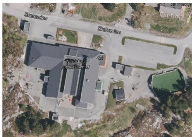
Oversiktsbilde av oppvekstsenteret, bygninger og uteområdet
