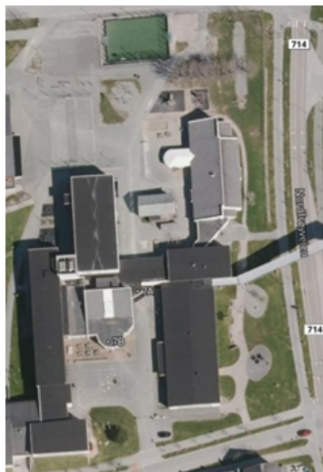
Oversiktsbilde av skolen, bygninger og uteområde
