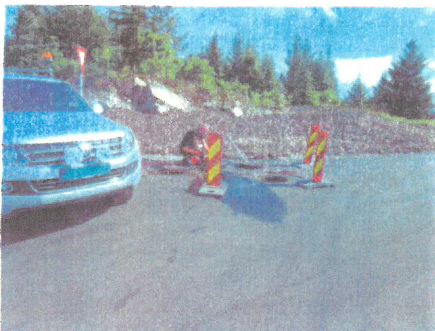
Trykkprøving av vannledning!
