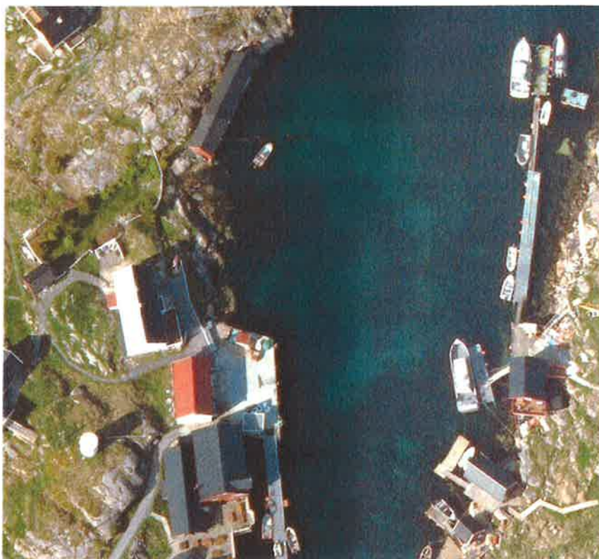
Kaianlegg på Bogøyvær.
