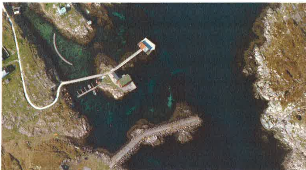
Kaianlegg på Sauøya.
