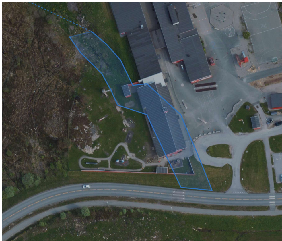
Figur 3.4 Opprinnelige bekkeløpet vist med blått. Innenfor dette området bør det forventes større løsmasseavsetninger og fare for organiske masser, sammenlignet med området ellers.
