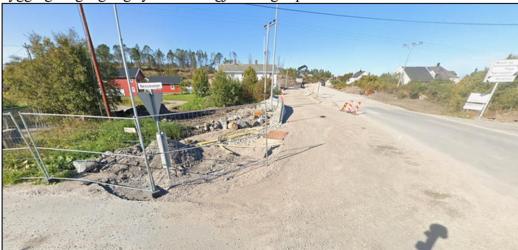
Figur 6.1 Grunnarbeider i området hvor Nessaveien møter Nordfrøyveien, bildet er fra sep. 2024 (google maps).
