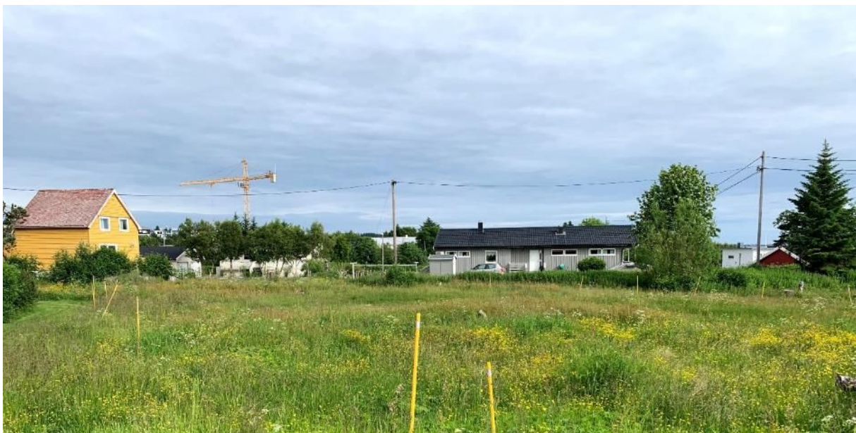
Figur 13. Eksisterende bebyggelse med arkitektur fra 60 og 70-tallet.
