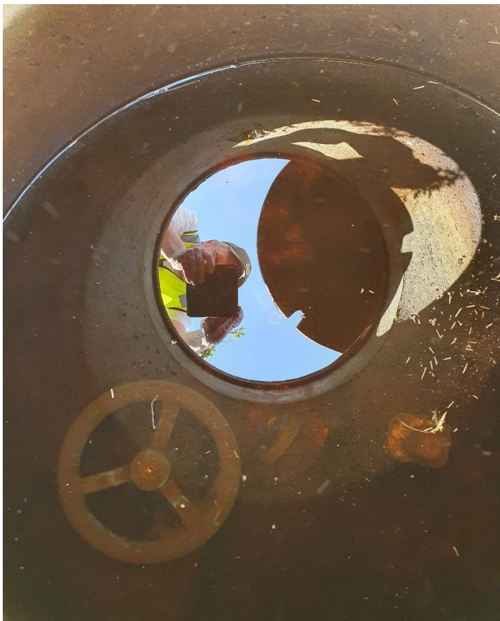
Bilde 4: Bilde av eksisterende vannkum i vest
