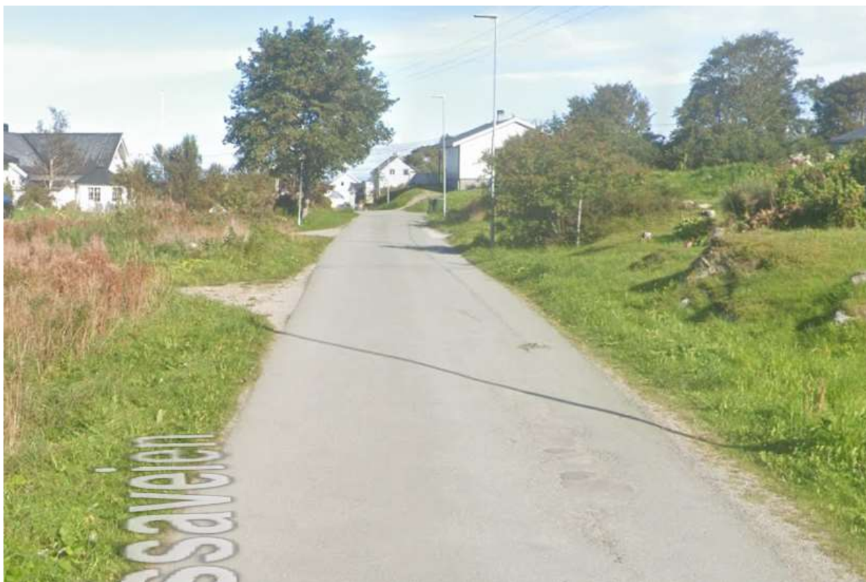
Figur 5: Eksisterende boliggate i Nessaveien
